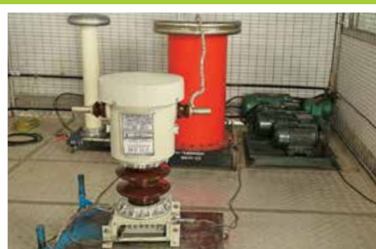
11 kV ODCT test in operation
